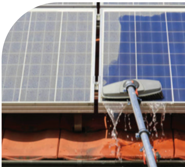
Slika 14: Čišćenje fotonaponskih panela
