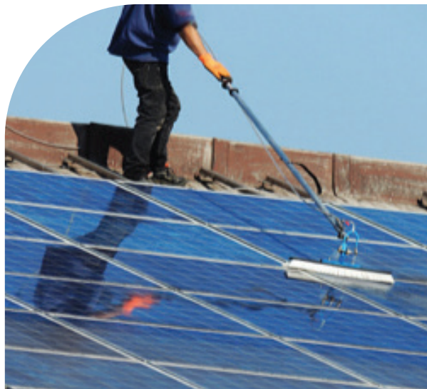
Slika 13: Čišćenje fotonaponskih panela
